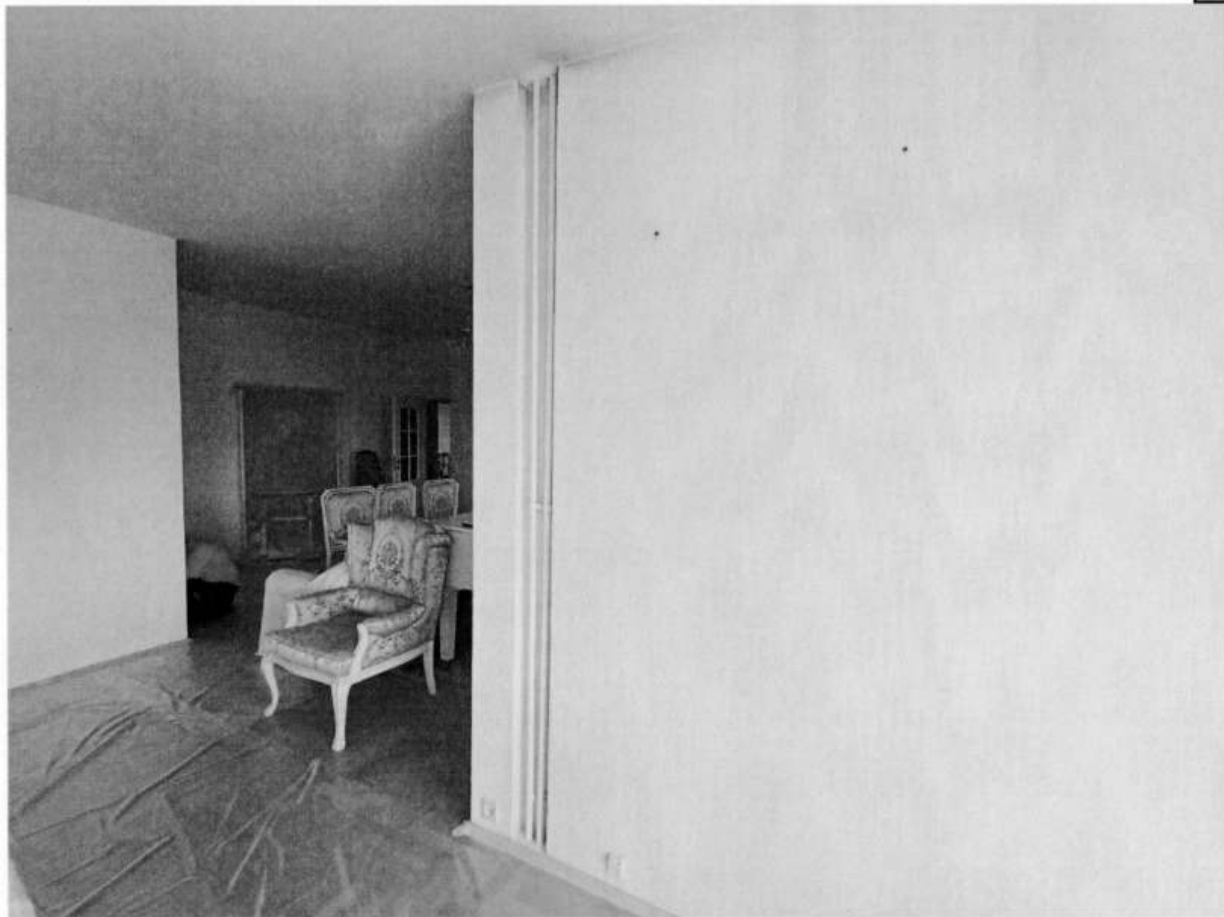
Фото №5. Местоположение раскладки доступа к стоякам отопления.
