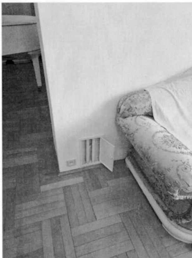
Фото №6. Местоположение раскладки доступа к стоякам отопления.
